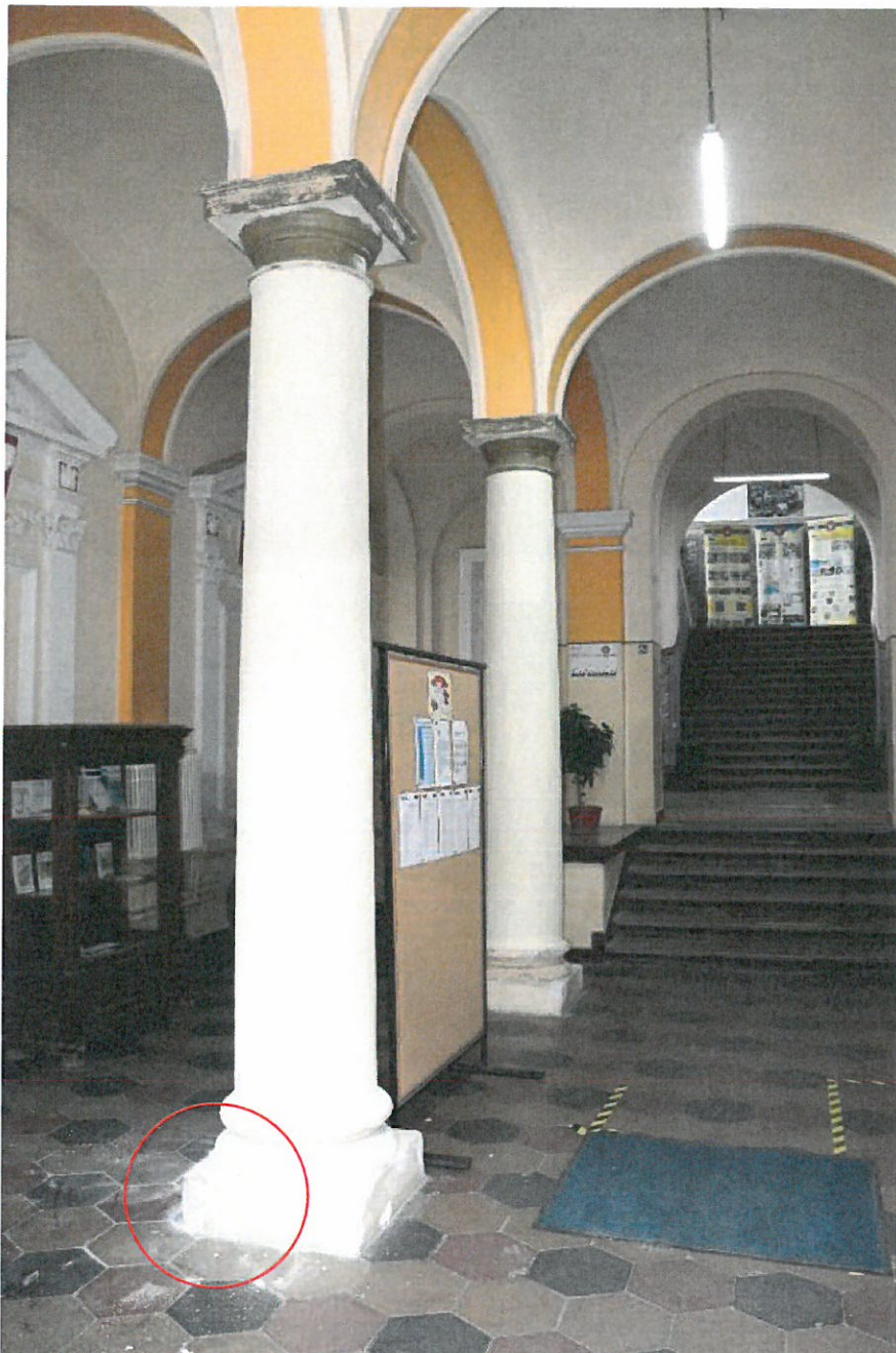
Foto.a1. Sondajul S1, vedere - Hol Acces principal, parter, bază coloană.
